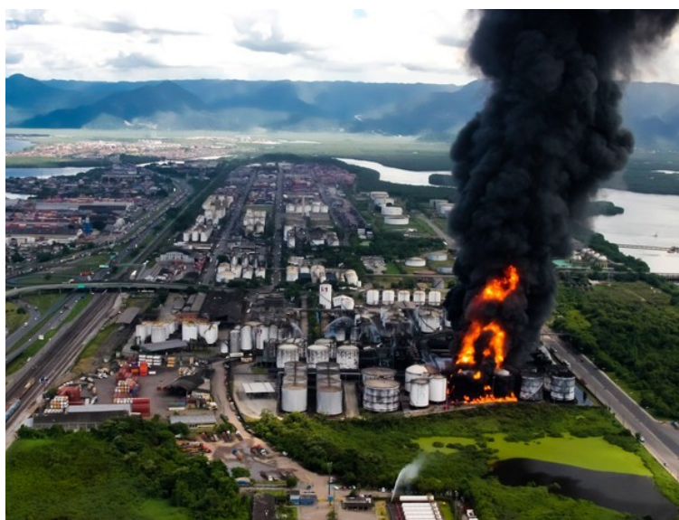
Figura 6 - Incêndio em terminal de granéis líquidos inflamáveis em Santos (Foto: Sérgio Furtado). Fonte: G1- Santos e Região.
