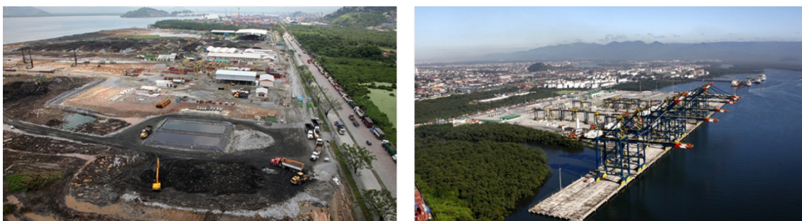
Figura 7 - Terminal da BTP - Fase de descontaminação e obra concluída.
