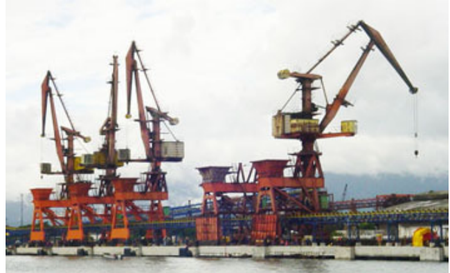
Terminal tem que utilizar trabalhadores habilitados no Ogmo
